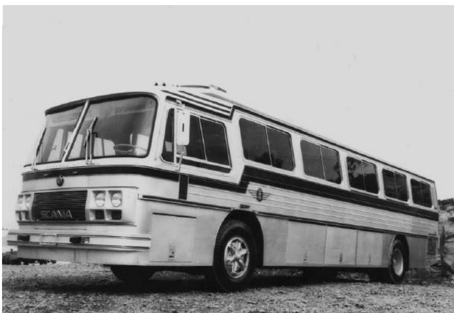
Foto 02 - Na primeira metade da década de 1970, a Scania apresentou ao mercado brasileiro o seu chassis BR 115, que possibilitou a construção de bagageiros passantes. Algum tempo depois ela atualizou seu modelo, com a nomenclatura BR 116.
