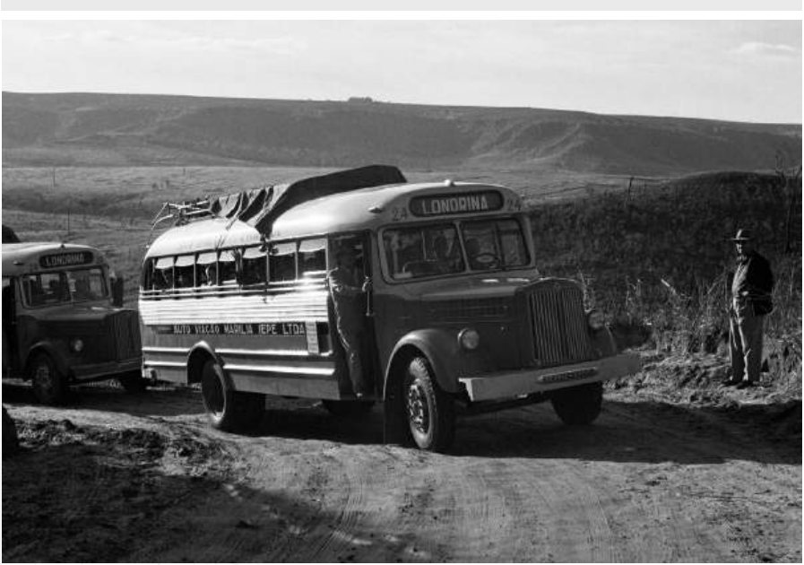
Foto 04 - No início, as estradas de terra promoviam grandes desafios para quem operava os ônibus entre as cidades. Nesta foto, um modelo de caminhão Scania transformado para o transporte de passageiros no norte paranaense.
