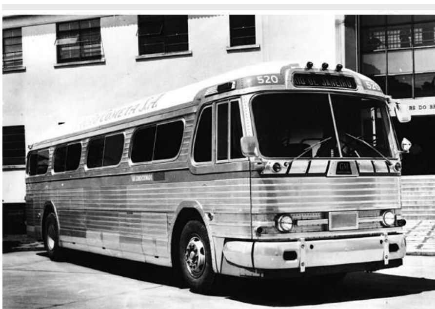
Foto 03 - O “Morubixaba” General Motors PD 4104, modelo que provocou a mudança de conceito dos ônibus estradeiros.
