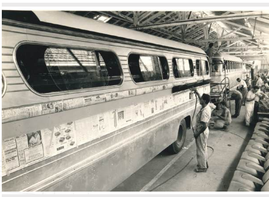
Foto 05 - Fábrica da Ciferal, no Rio de Janeiro, onde se produzia os ônibus com estrutura de duralumínio, mais leve e resistente.
